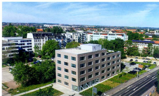
Bild 2 Das auf die Standorte Dresden, Leipzig und Berlin verteilte Unternehmen verfügt über eine langjährige Planungserfahrung im TGA-Bereich.
